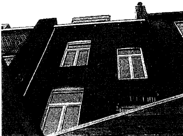
Vue de la façade sur cour
